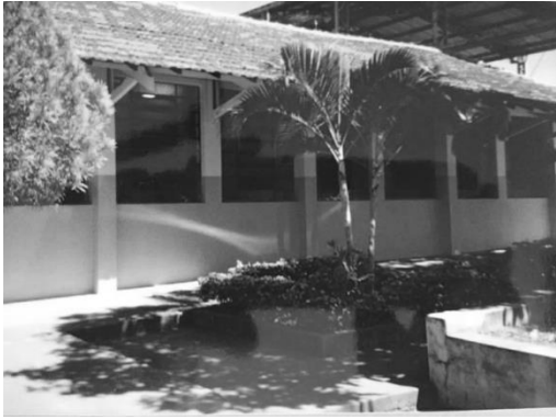
Parte externa das salas de aulas
